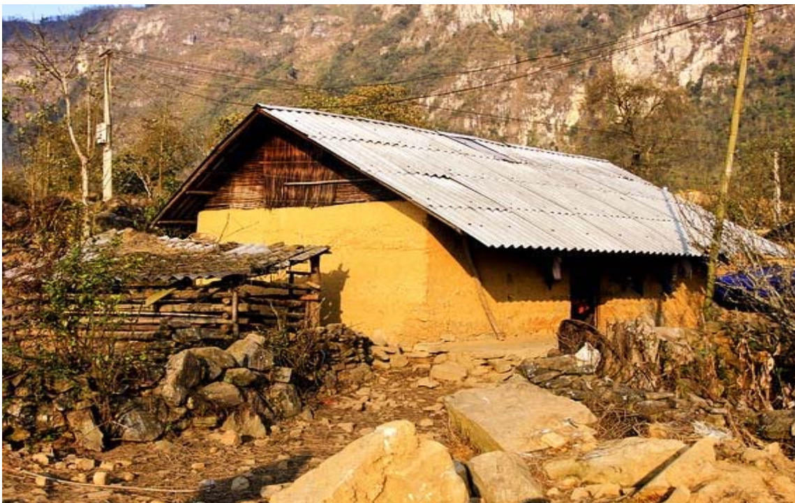
Nhà trình tường truyền thống của người Hà Nhì, Lào Cai - Nguồn: http://www.vannghequandoi.com.vn/802/news-detail/397503/but-ky-phong-su/nguoi-ha-nhi-da-co-nhieu-cai-chu.html
